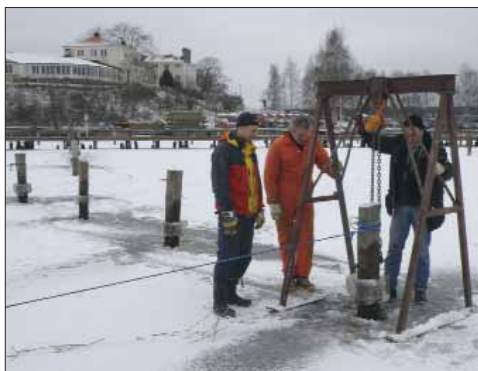
Den sista delen av vågbrytaren tar form Nu skall det vara tätt mellan land och den vågbrytande poptonen.
