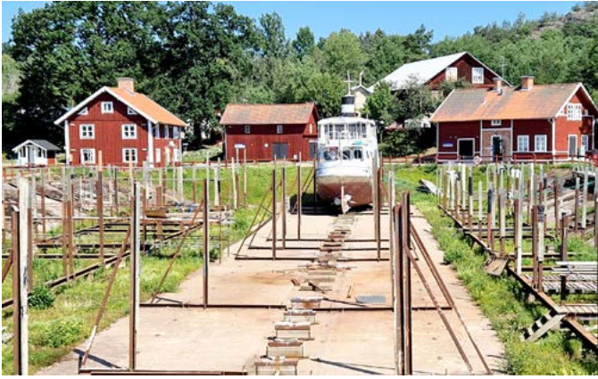
Inget vatten under kölen i sommar för den här båten i torrdockan vid Söderköping.
